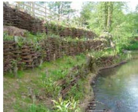
Figure 23 : Exemple de barrières à l'érosion (Source : [www.genie-vegetal.eu](http://www.genie-vegetal.eu))
